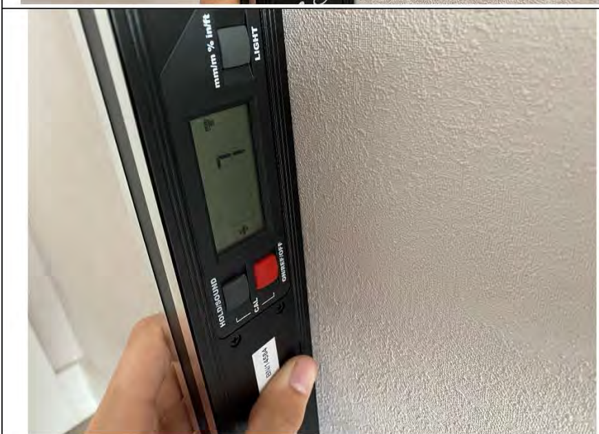
Фото №9. Измерение уровня стен в спальне.
