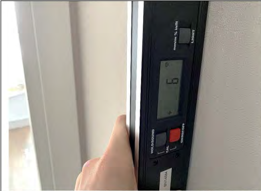
Фото №7. Измерение уровня стен в коридоре.
