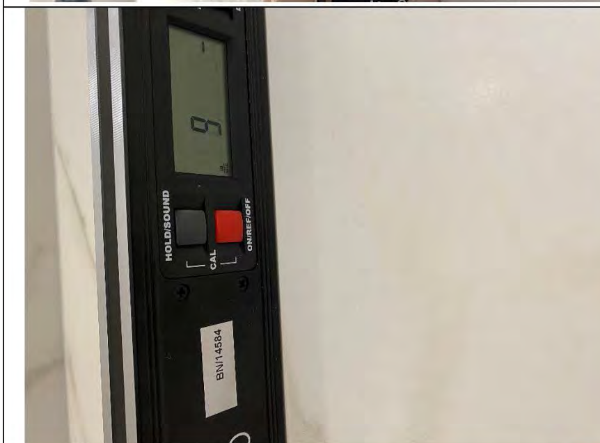
Фото №11. Измерение уровня стен в ванной комнате.
