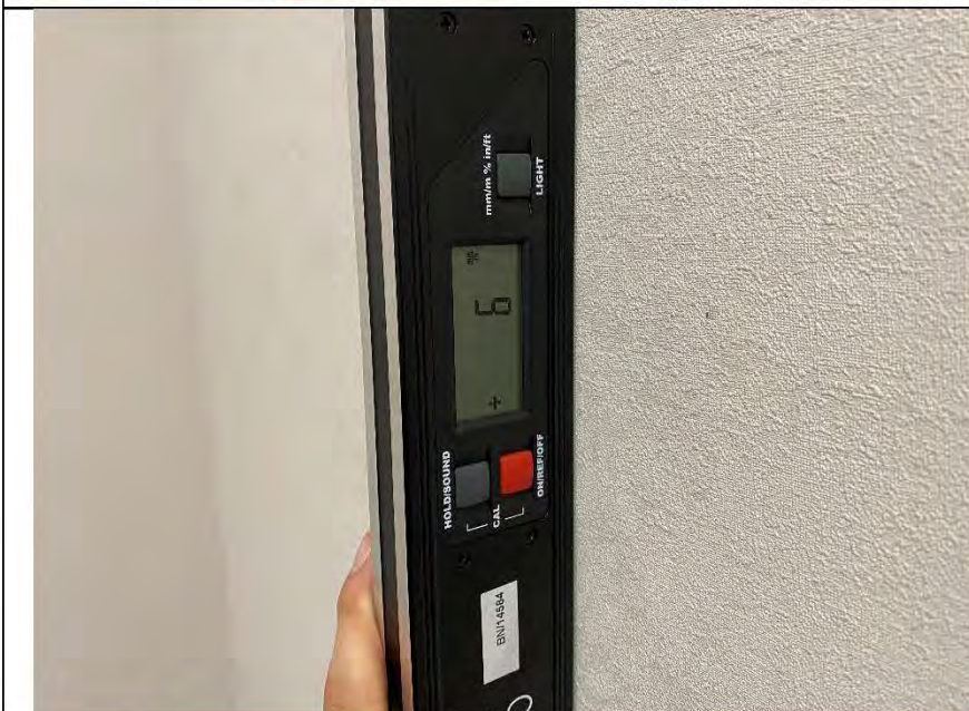
Фото №8. Измерение уровня стен в кладовой.
