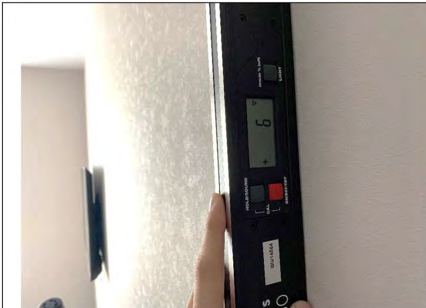
Фото №10. Измерение уровня стен в кухне.
